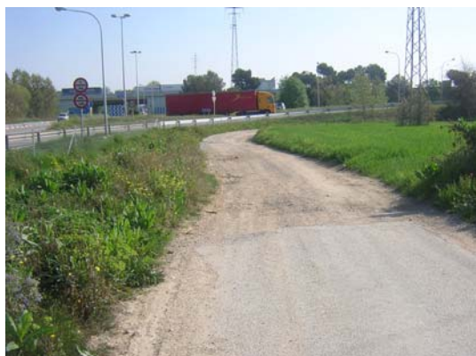
Tram 1: Estat del ferm
