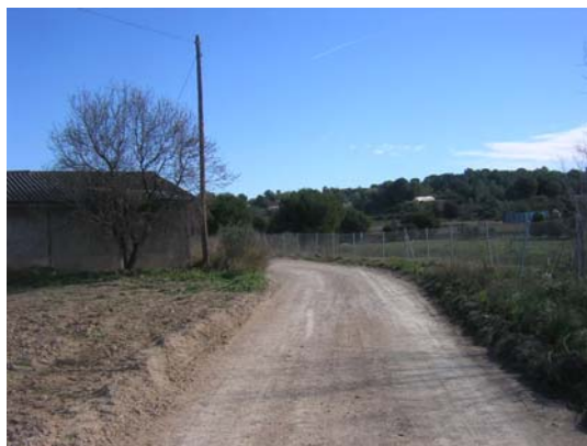
Tram 1: Estat del ferm
