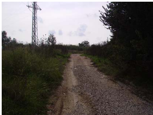
Tram 1: Estat del ferm
