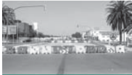
Quant la travessia passi a l'Ajuntament es preveu executar la rotonda provisional de la cruïlla amb el carrer de Barba i Roca.
