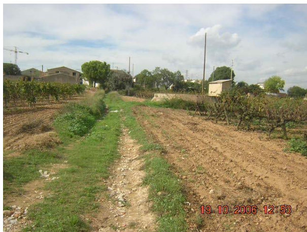
Tram 1: Estat del ferm
